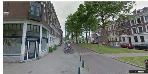
Figuur 6.20 Verharding van stoepen en overgang: betontegels; geen stoeprand bij kruisingen.
