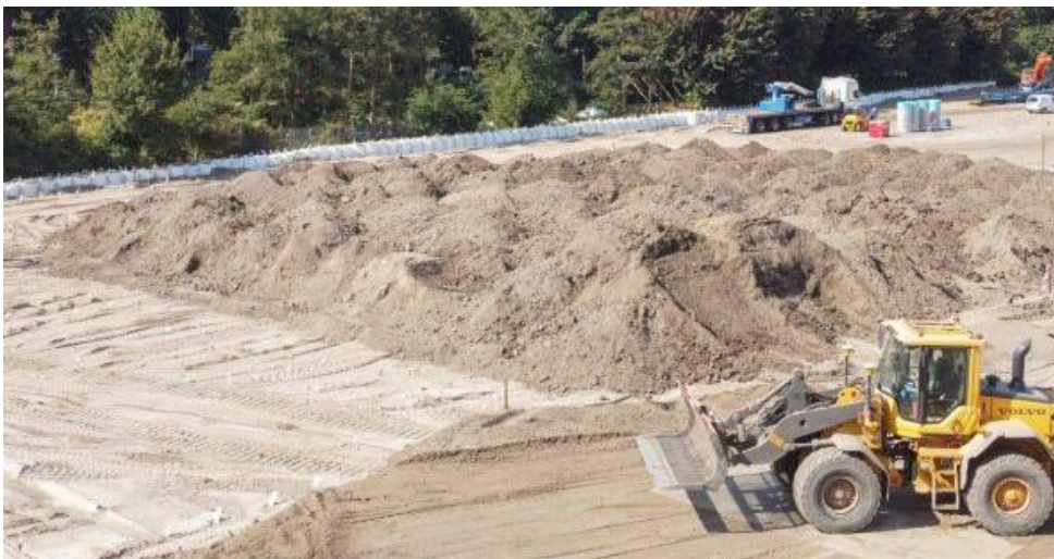
Start bouwrijp maken van Nieuw Kralingen, afgelopen zomer
